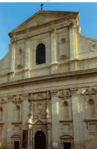
Lapidaire Façade rue de la République
